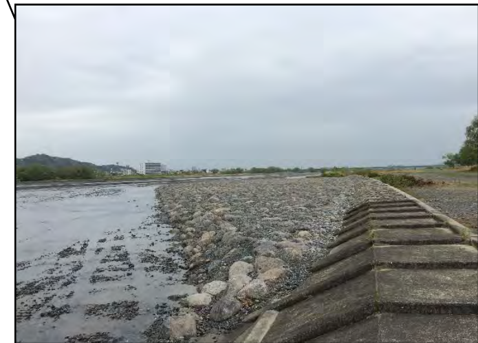
試験施工状況
