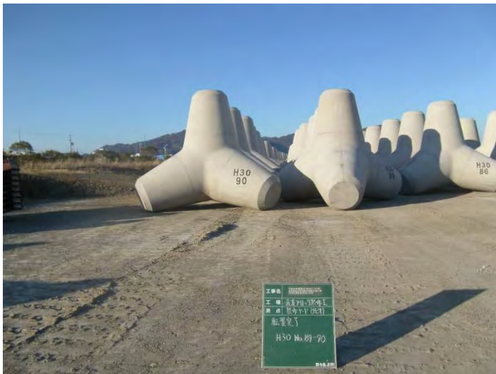
【2号消波堤復旧 消波ブロック製作】
