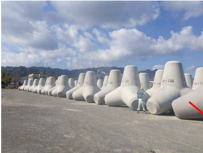
【2号消波堤復旧 消波ブロック製作】
