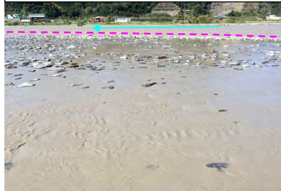
【(2)砂州中央部(対岸を望む)】
