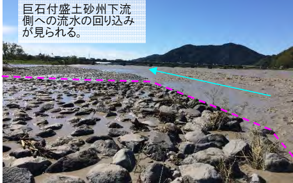
【(4)下流方向(下流を望む)】
