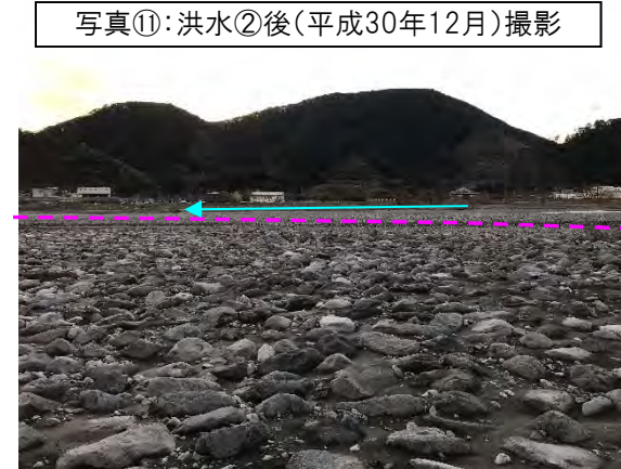
【(2)砂州中央部(対岸を望む)】
