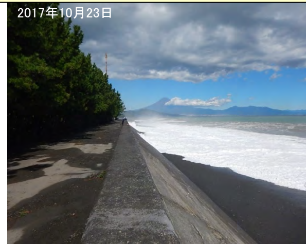
1, 2号消波堤背後の堤防状況
