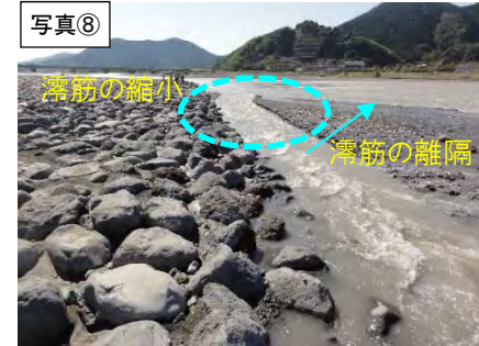
【(3)上流側(下流を望む)②撮影】
