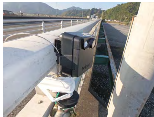
【定点カメラ設置状況(定点カメラ)】
