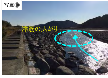
【(3)上流側(下流を望む)③撮影】
