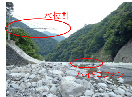
大河内砂防堰堤の観測状況
