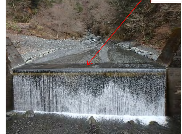
湯の島第1砂防堰堤 改良後
