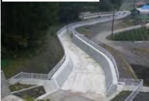
ウラの沢流路工 (H25完成)
