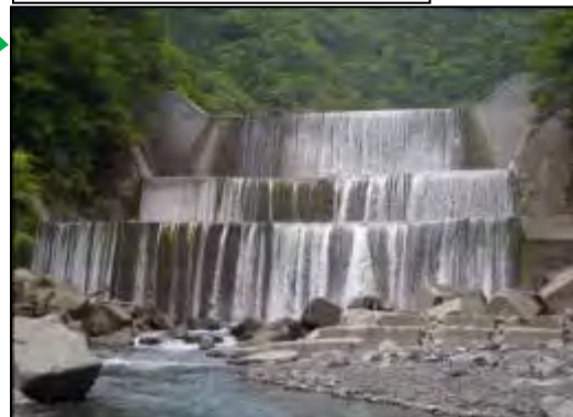
金山砂防堰堤修繕前(H25.5.28撮影)
