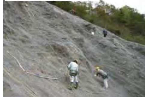
大谷山腹工 (吹付工)
