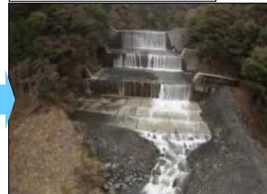
金山砂防堰堤修繕完成(H26.3.4撮影)
