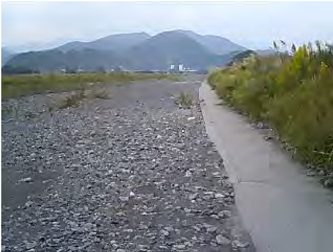
河床上昇による低水路の埋塞（右写真：左岸5k付近の状況・平成19年）
