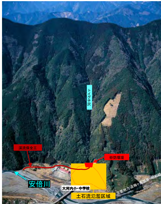
トイグチ沢土石流対策
