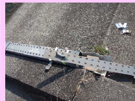
水位計設置状況
