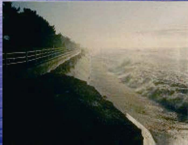
高波で削り取られた砂浜（平成6年）
