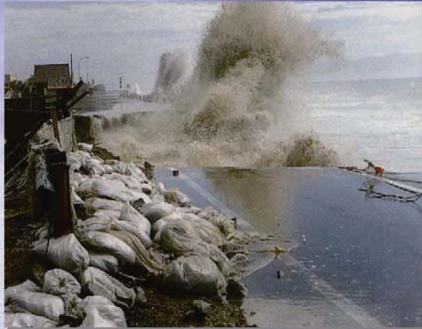
台風による静岡海岸の被災状況（昭和56年）
