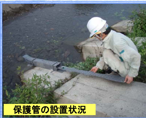
保護管の設置後(5.0k右岸)
