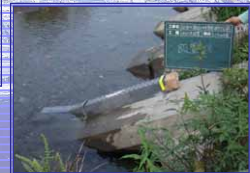
保護管の設置状況 (1.0k)
