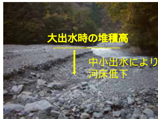
【金山砂防えん堤堆砂敷 (H15)】
