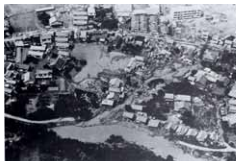
丸子川の破堤箇所と浸水状況(昭和49年、台風8号)
