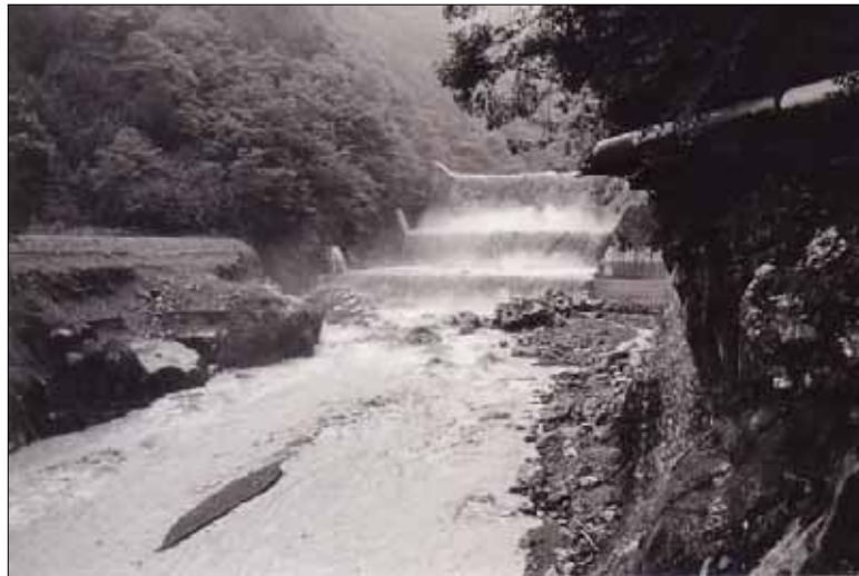
【昭和57年災害時直後の金山砂防えん堤】
