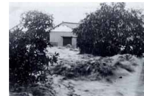
丸子川の破堤箇所より流れ込む濁流(昭和49年、台風8号)
