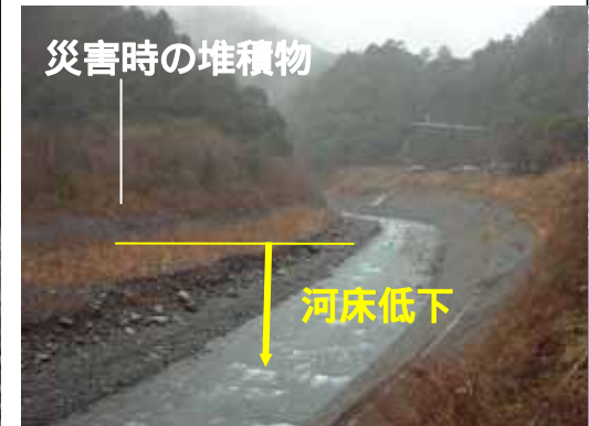
【金山砂防えん堤下流 (H14)】
