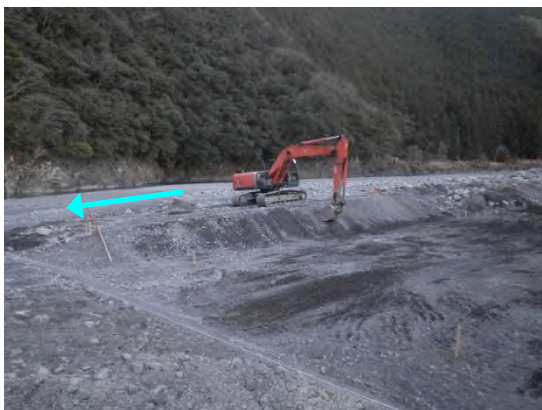
河道掘削の状況
