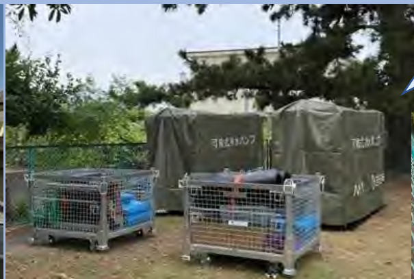
【R7年度】可搬式排水ポンプの設置 【普通河川から二級河川坂口谷川への流出部】
