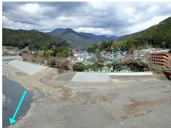
護岸整備の状況
