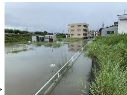
令和7年台風15号の際の冠水箇所→
