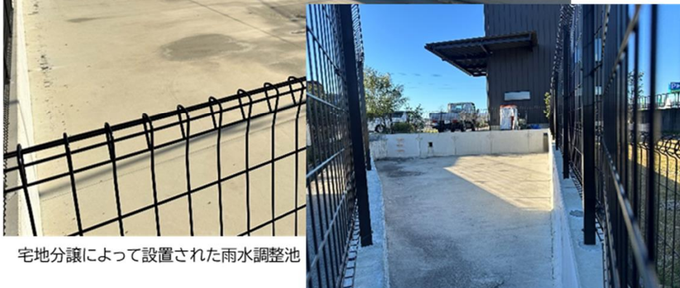
店舗・事務所開発によって設置された雨水調整池
