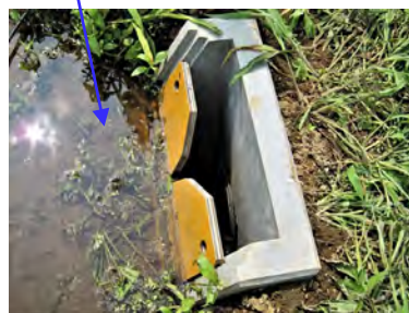
水位調整板の設置イメージ
