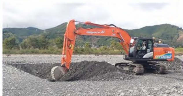
整備イメージ（河道掘削）
