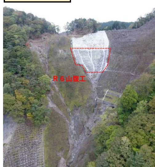
② 西日影沢 (山腹工 (完成))
