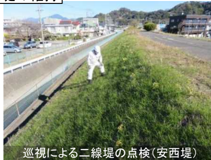
巡視による二線堤の点検（安西堤）
