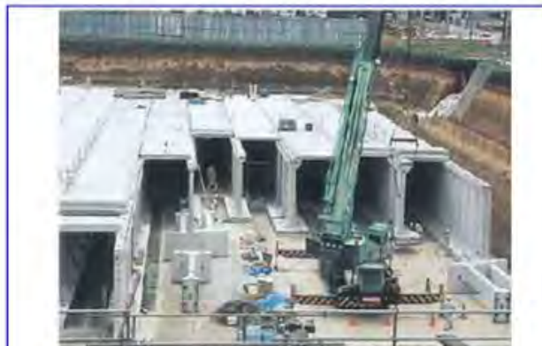
◆地下方式 調節池 イメージ写真
