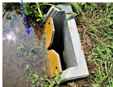
水位調整板の設置イメージ
