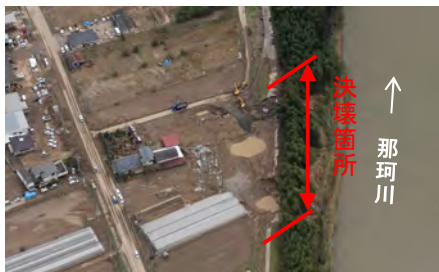
写真③ 堤防決壊状況（那珂川左岸40.0k）
