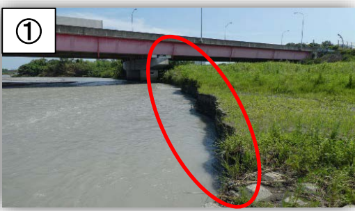
静岡市下川原地先(安倍川右岸1.5k) 7/16 9:40頃現地調査
