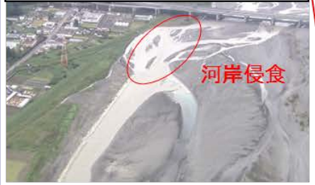
【平成12年9月洪水】 左岸12k河岸侵食
