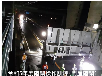
令和5年度陸閘操作訓練(門屋陸閘)
