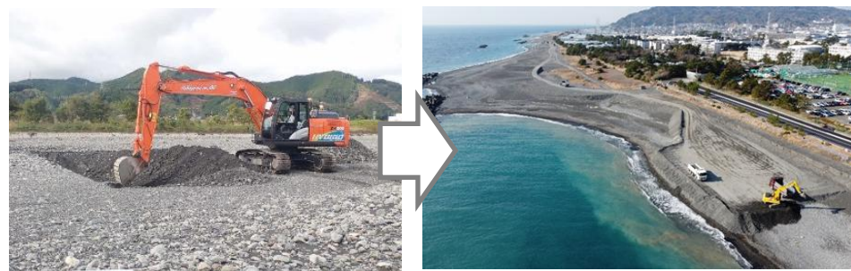
河道掘削土砂は養浜材として有効活用
