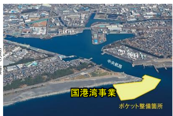
清水港湾での浚渫箇所
