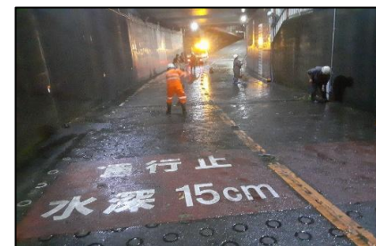
排水作業終了状況
