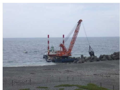
海上養浜の投入状況
