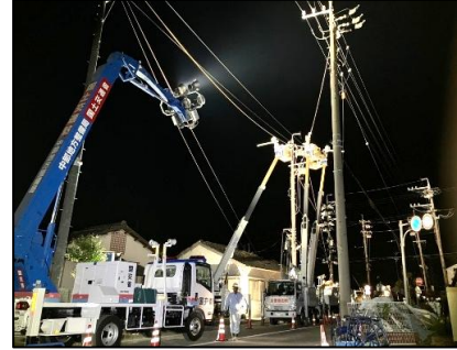
照明車を牧之原市での中部電力の夜間復旧作業にも使用しました。
