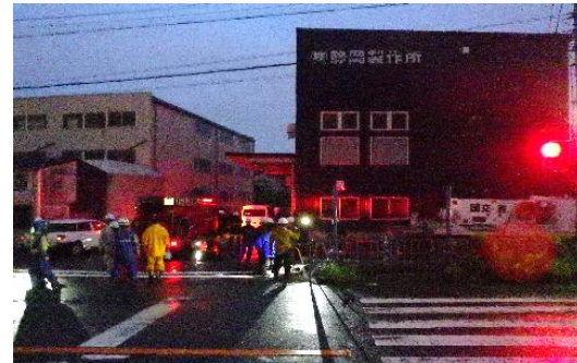
令和6年8月台風10号での静岡市への排水ポンプ車派遣
