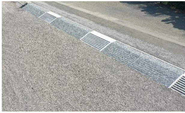
低水護岸工(埋め戻し後)
