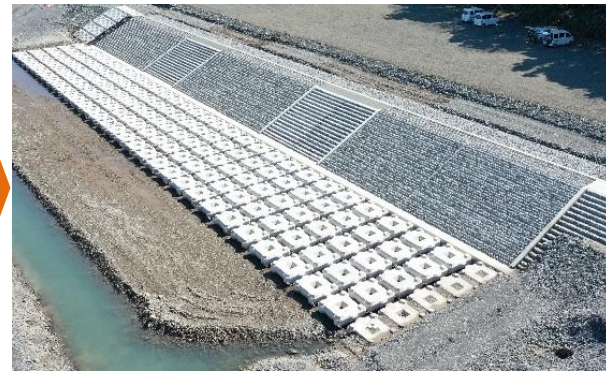
低水護岸工(埋め戻し前)
