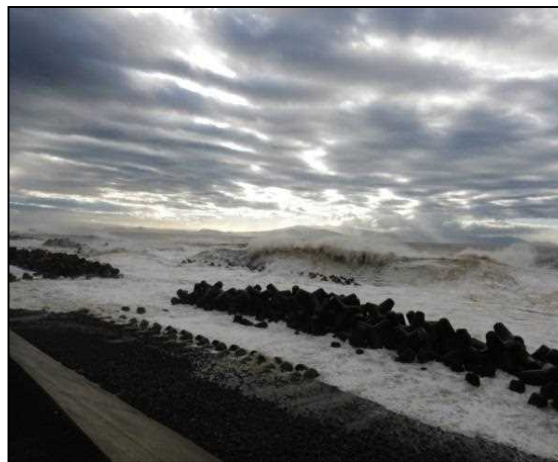
高波浪を消波する離岸堤 (平成29年10月23日 台風21号)
