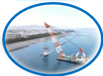
有脚式離岸堤等の整備
