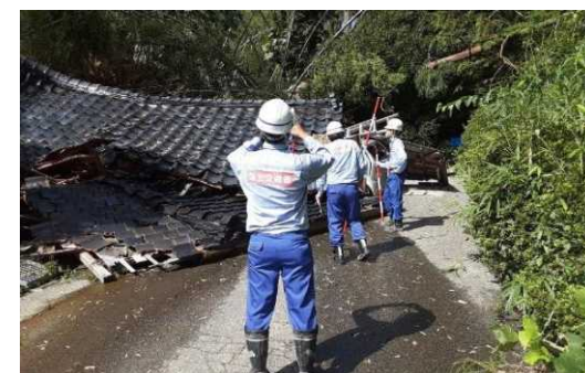
令和6年10月台風第20号能登半島 被災状況調査（砂防）
