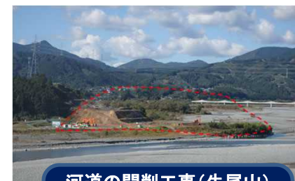
河道の開削工事(牛尾山)
