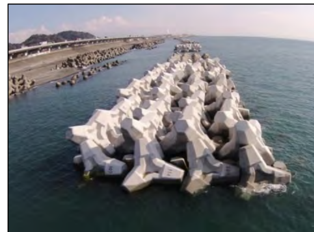
ブロック式離岸堤 整備イメージ
