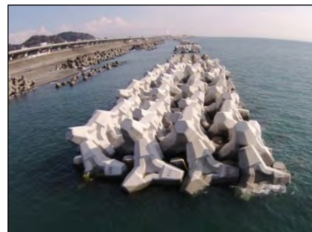
ブロック式離岸堤 整備イメージ
