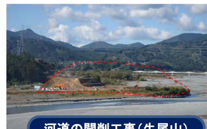
河道の開削工事(牛尾山)
