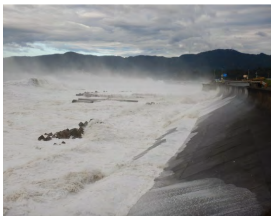
高波浪を消波する離岸堤 （平成29年10月23日）
