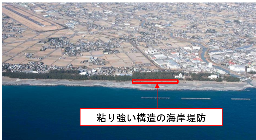
焼津市一色地先(焼津工区)
