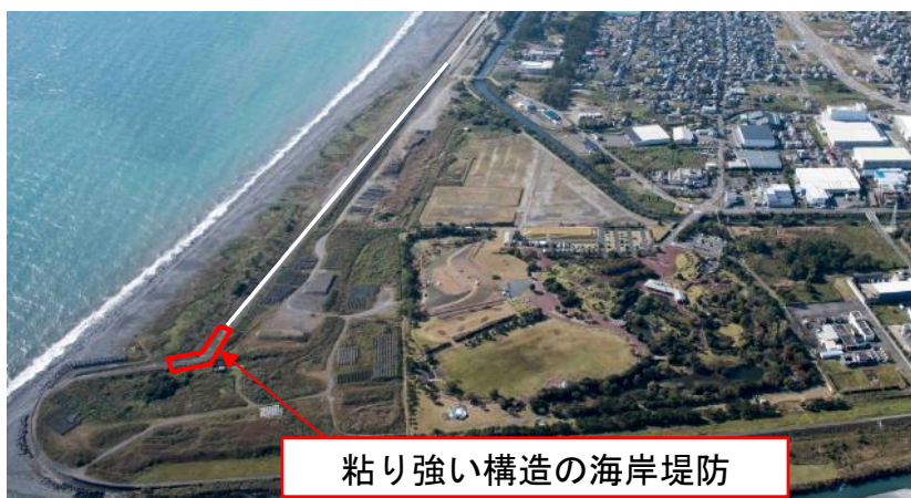
吉田町川尻地先(川尻工区)
