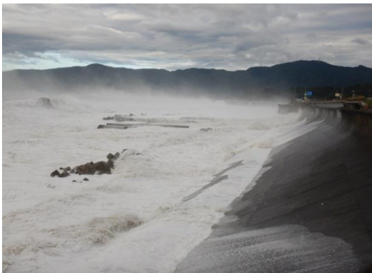
台風21号来襲時による高波浪を消波する離岸堤 (平成29年10月23日 6時30分頃)
