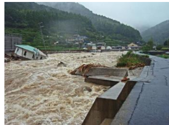
平成23年（2011年）台風12号 三重県熊野市井戸町での河岸侵食の様子
