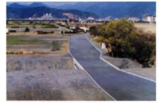
③緊急用河川敷道路
