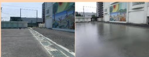
過年度整備箇所における貯留時の状況
