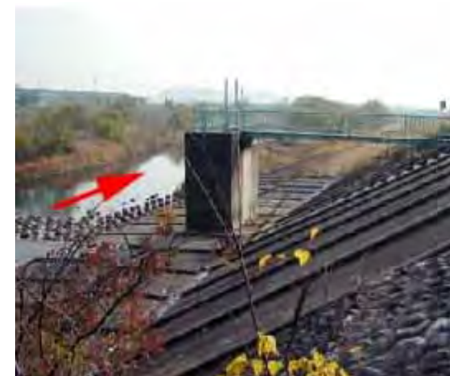
堤防の損傷なし
