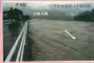
平成23年台風12号による大井川の出水状況(川根本町 千歳駅付近)
