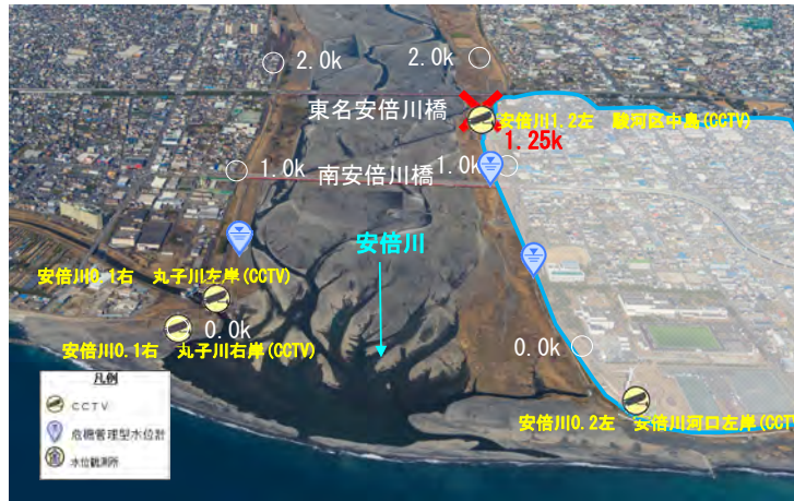
○危険箇所付近の斜め写真(1.25k付近)
