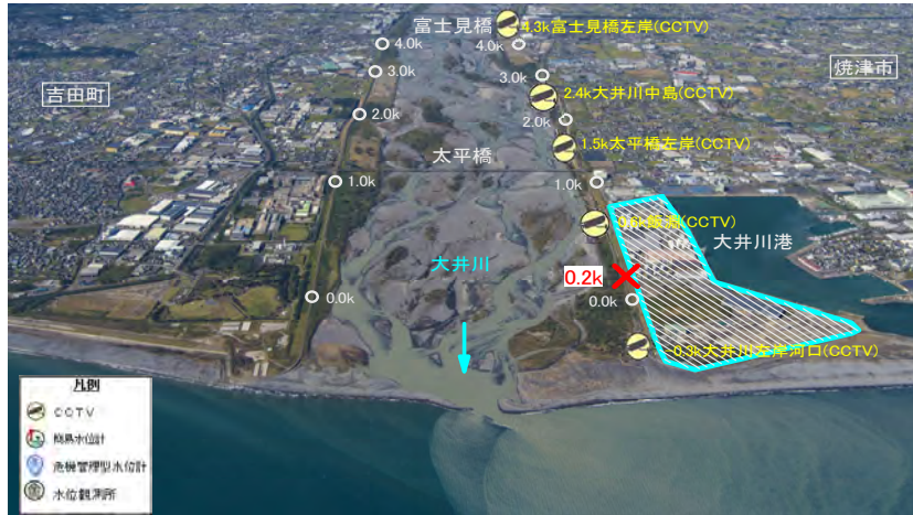
○危険箇所付近の斜め写真(0.2k付近)
