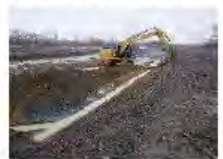
河道掘削 (石狩川水系、北海道開発局)
