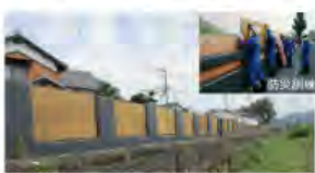
自主防災活動による畳堤設置 (播保川水系、たつの市)
