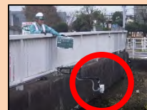
危機管理型水位計の設置(伊太谷川)
