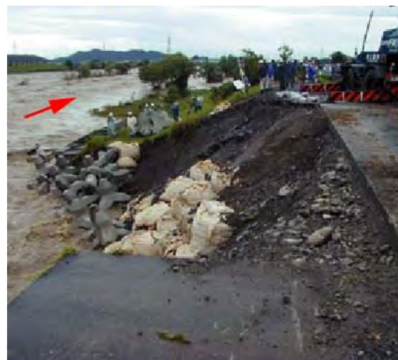
堤防の一部損傷
