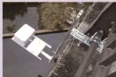
現場実証実験第一弾(輪見川水系 烏山川)
