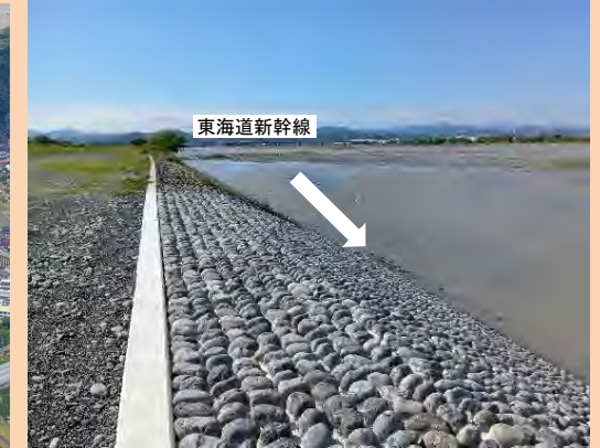
中河地区 低水護岸 L30m
