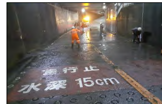
排水作業終了状況
