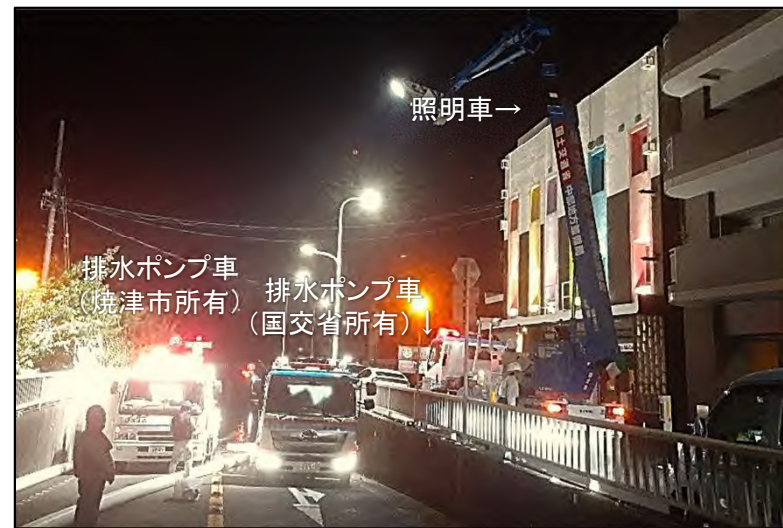
ポンプ車・照明車による排水作業状況
