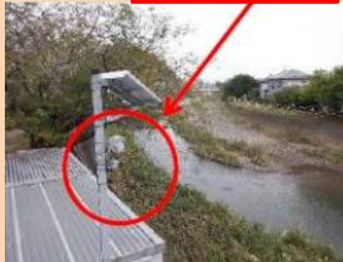
河川監視用カメラ
