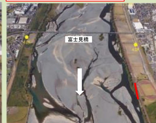
西島地区 護岸改修 L=50m
