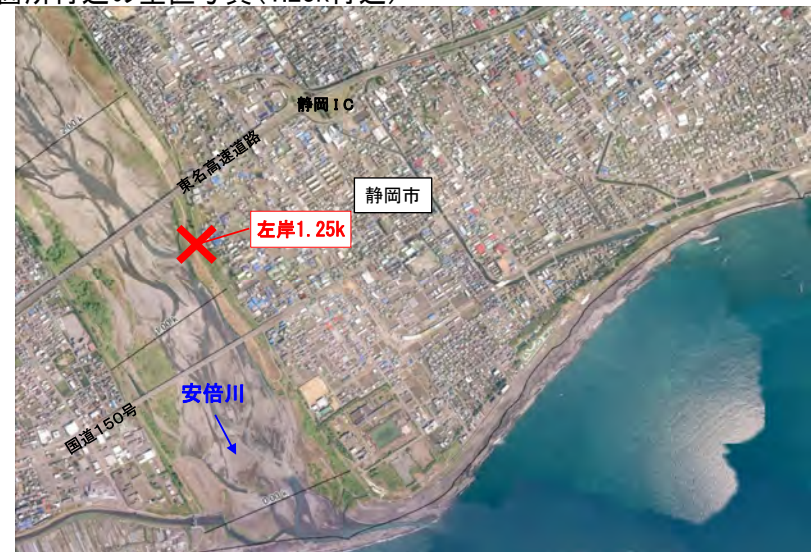
○危険箇所付近の垂直写真(1.25k付近)
