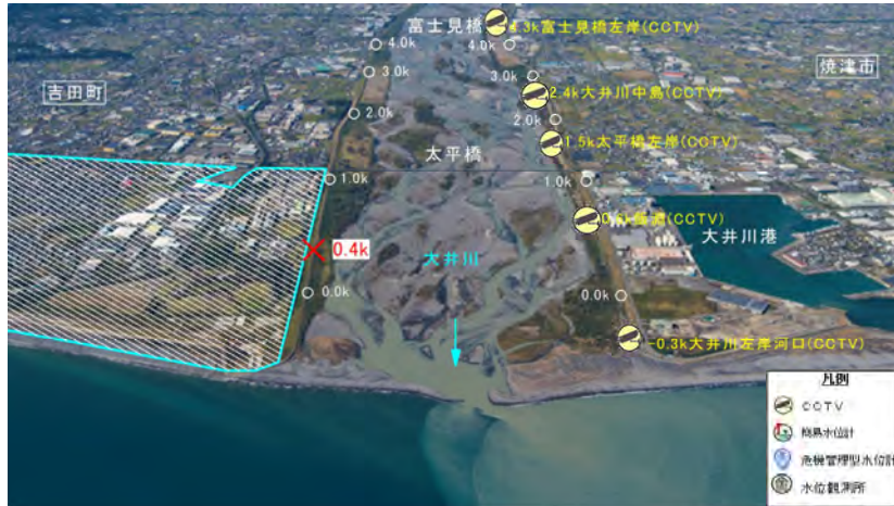
○危険箇所付近の斜め写真(0.4k付近)
