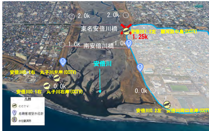
○危険箇所付近の斜め写真(1.25k付近)
