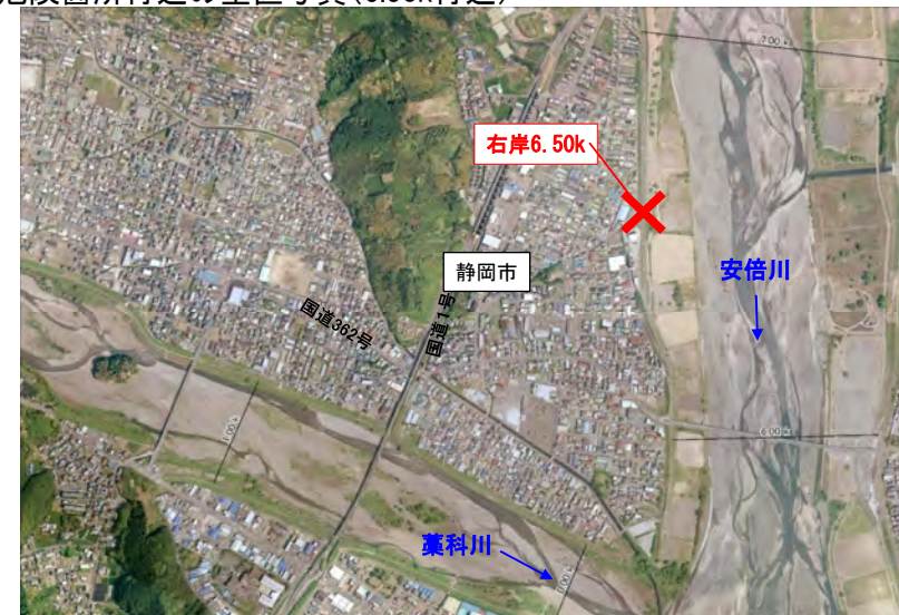
○危険箇所付近の垂直写真(6.50k付近)
