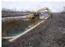
河道掘削 (石狩川水系、北海道開発局)
