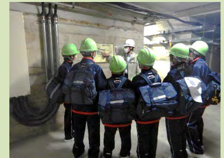
ダム堤体内での説明状況
