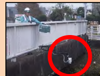
危機管理型水位計の 設置(伊太谷川)
