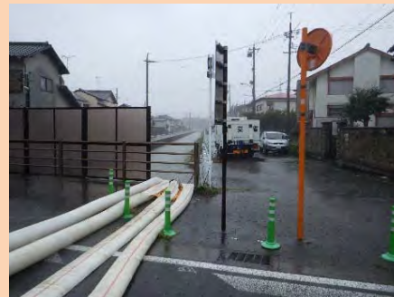
排水ポンプ車の実動派遣
