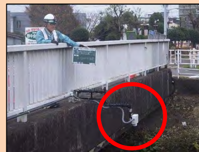
▲危機管理型水位計の設置(伊太谷川)
