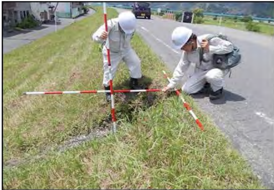
H27施設点検状況
