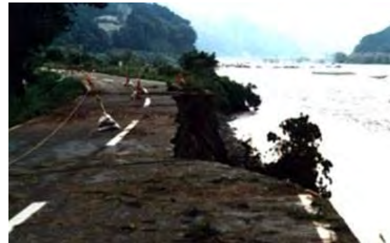
洪水により堤防が半壊した安倍川左岸堤防（H3.9）
