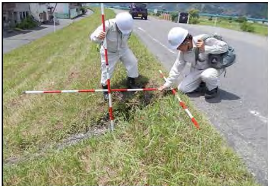
H27施設点検状況
