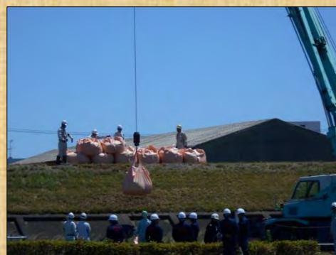
大型土のう工法
