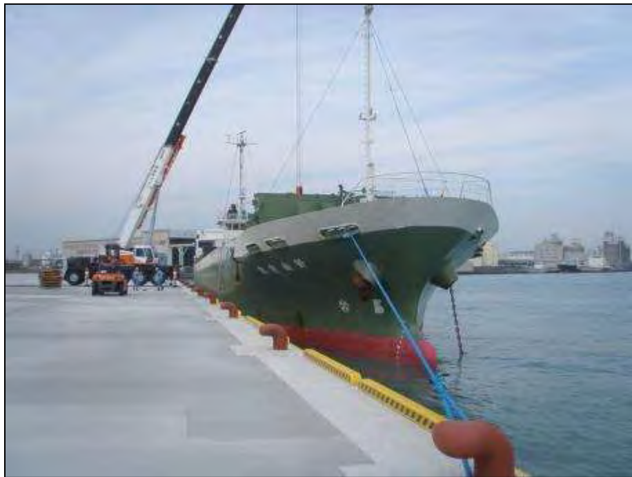
耐震強化岸壁の整備
