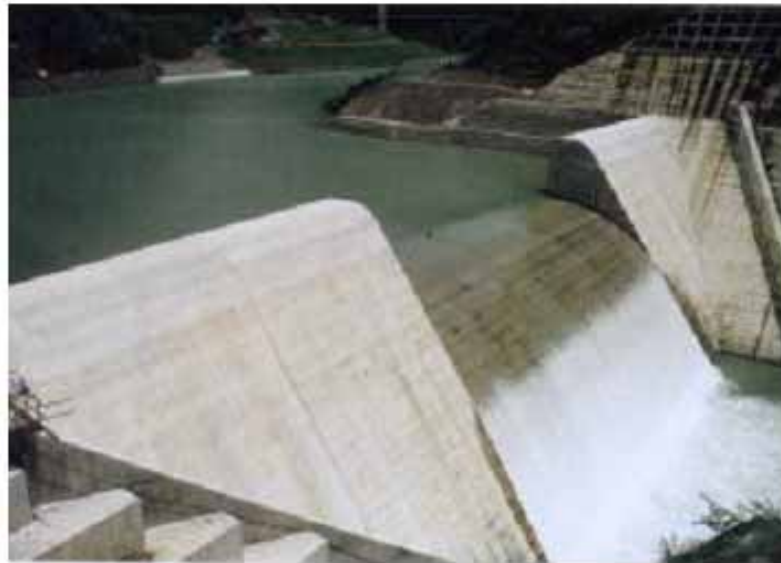
図4.6.5 長島ダム上流に設置された貯砂ダム
